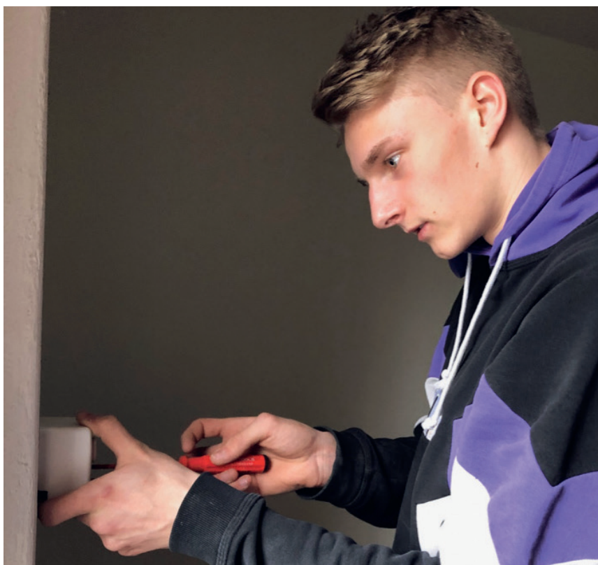
Nils Gasser bei der Demontage einer Steckdose (Bild Sandro Imfeld).
